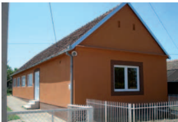
Slika 1 Stambena zgrada 0. kategorije oštećenja, lipanj 2014., Izvor: Ministarstvo graditeljstva i prostornoga uređenja
