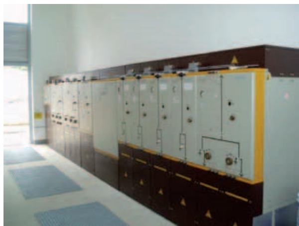
Slika 17 Prikaz složene konfiguracije VDAP modula u TS 10(20)/0,4 kV-tvornica stočne hrane Varaždin
