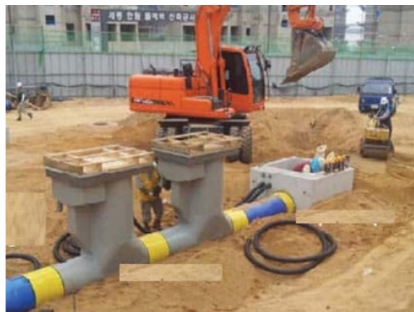
Slika 5 Izvedba kontrolnih okna [15]
