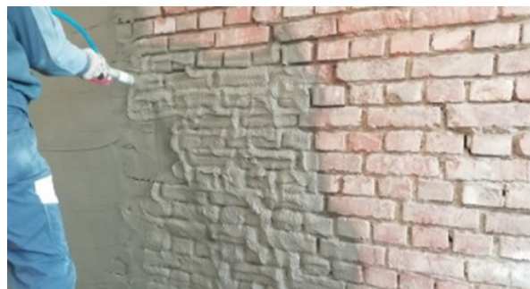
Slika 3 Pripremljena podloga za postavu FRCM-a: nanošenje prvog sloja morta [8]
