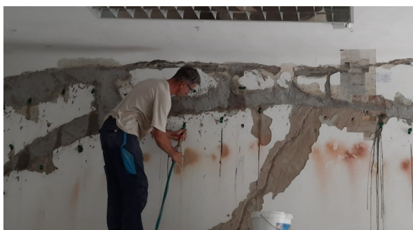
Slika 12 Injektiranje žida [izvor: fotografija autora D.W.]
