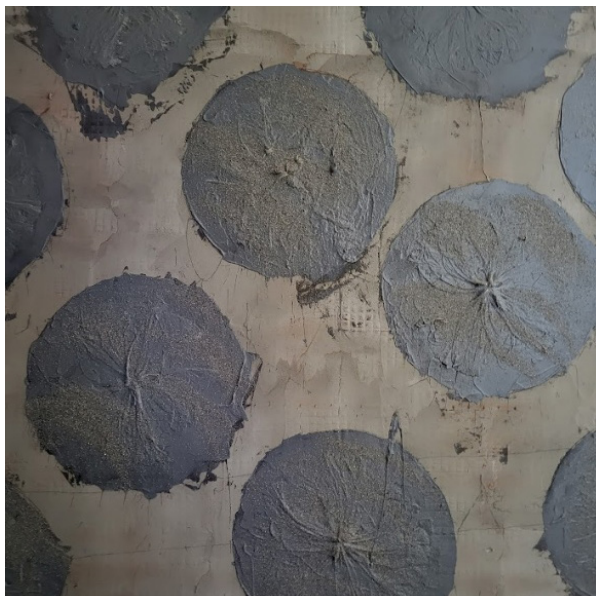
Slika 5 Ugrađena sidra s kvarcnim posipom [izvor: fotografija autora D.W.]
