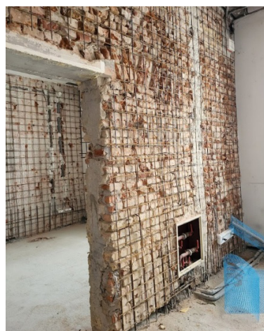
Slika 2 Ugrađeni ankeri i postavljena mreža prije nanošenja betona [izvor: fotografija autora D.W]
