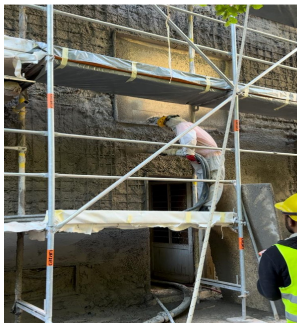
Slika 8 Zid prije nanošenja mlaznog betona i postupak torkretiranja [11]
