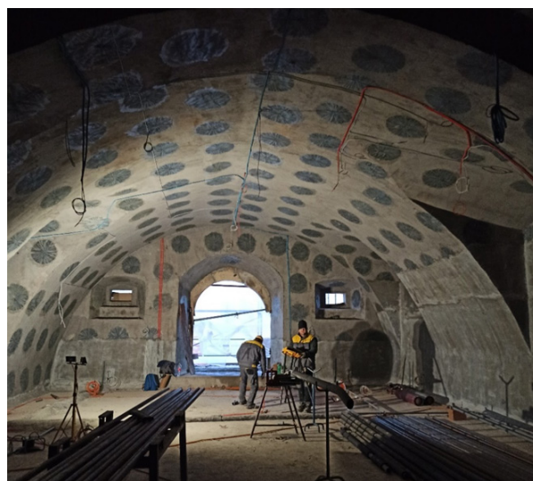
Slika 10 Spahijski podrum: FRCM sustav (podrumski svod) [12]
