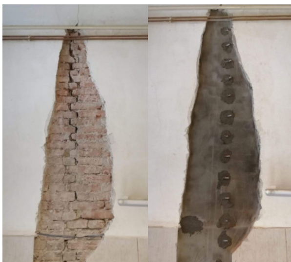
Slika 7 Pogled na zid prije i nakon injektiranja [11]
