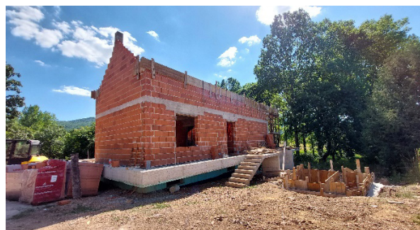
Slika 9a Status objekta 29.06.2025.: sjeverno i istočno pročelje [4]
