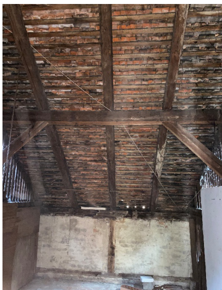
Slika 13 Drveno krovšte stambene zgrade u Ulici Pavla Hatza, Zagreb (autorska fotografija)
