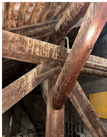
Slika 6 Spoj glavnih nosivih elemenata drvenog krovišta stambene zgrade u Ulici Janka Grahora, Zagreb (autorska fotografija)
