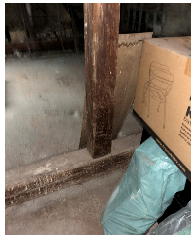
Slika 11 Spoj stup-greda drvenog krovišta stambene zgrade u Ulici Janka Grahora, Zagreb (autorska fotografija)
