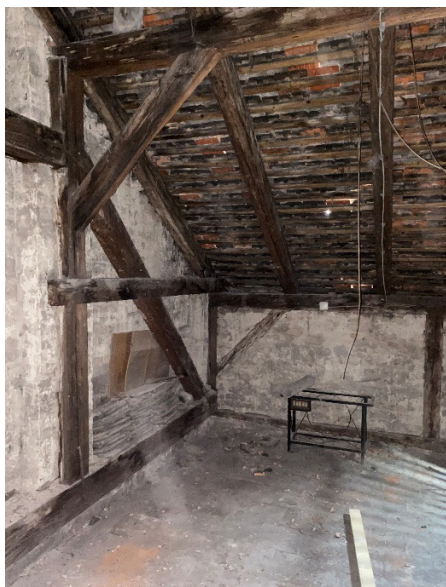
Slika 12 Drveno krovšte stambene zgrade u Ulici Pavla Hatza, Zagreb (autorska fotografija)
