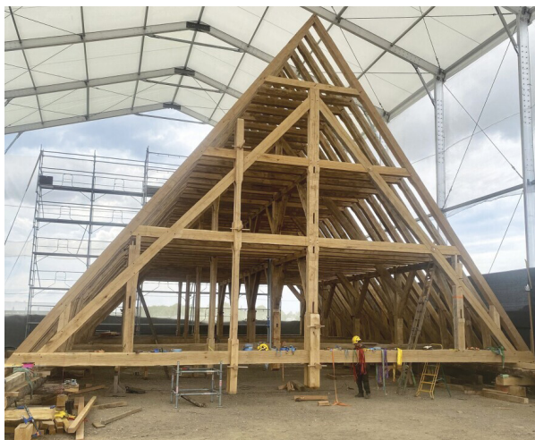
Slika 1 Krovna konstrukcija crkve Notre Dame. Ateliers Perrault izvodi praktičnu montažu krovnih okvira prije transporta na gradilište [3].
