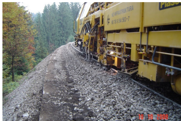
Slika 17 Prikaz strojnog reguliranja kolosijeka po smjeru i visini [12]
