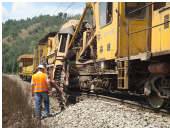
Slika 9 Prikaz strojnog prosijavanja zastorne prizme [13]
