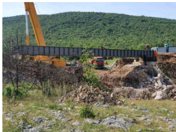
Slika 13 Ugrađen provizorij u 1. fazi radova [11]
