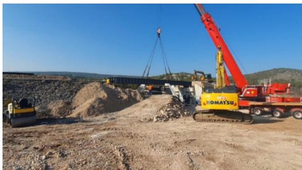
Slika 15 Početak demontaže provizorija - kraj 2. faze radova [11]
