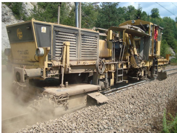
Slika 18 Prikaz strojnog planiranja zastorne prizme [13]
