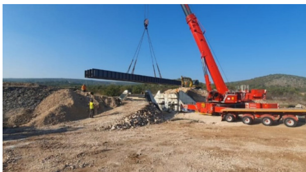
Slika 16 Demontaža provizorija - završetak radova na izradi novih upornjaka [11]
