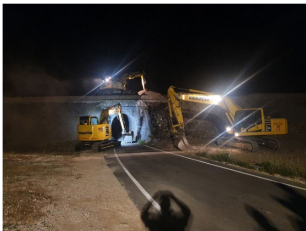
Slika 11 Početak radova na iskopu - 1. faza radova [11]
