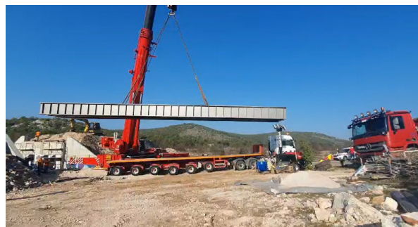
Slika 6 Uzdužni pogled - tipski željeznički provizorij [11]
