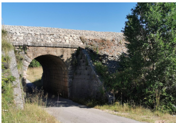
Slika 2 Pogled na podvožnjak sa južne strane [2]
