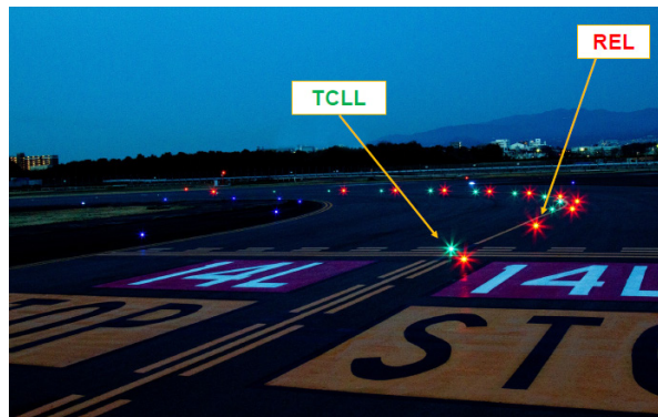
Slika 3 Nova ulazna svjetla na pistu – REL, Zračna luka Osaka, (2016.), [19]
