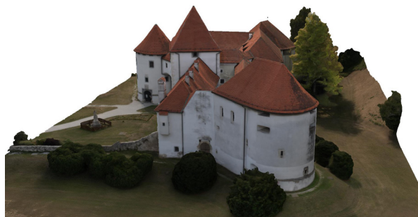
Slika 21 Bočna (istočna) strana Starog grada Varaždin Figure 21 Lateral (eastern) side of the Old Town of Varaždin (Izvor: autor)
