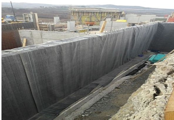
Slika 3 Nanošenje bentonitne membrane na stražnju stranu podrumskog zida hotela Roxanich Heritage Wine u Motovunu [1]
